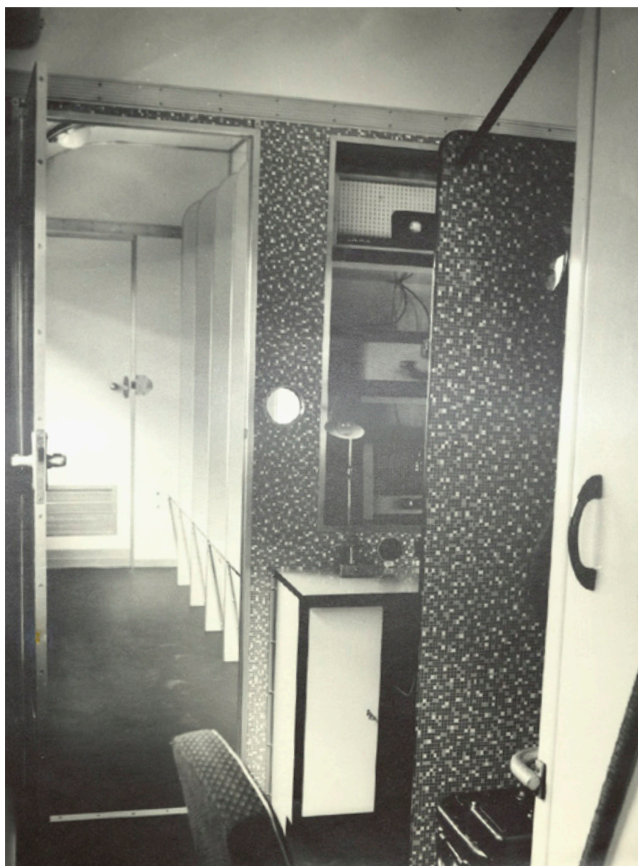
Fig. 8. Interior of the "Wrocław" X-ray mobile diagnostic unit. Source: State Archives in Wrocław, signature 332/0/71/1333. Ryc. 8. Wnętrze wagonu „wrocławskiego”. Źródło: Archiwum Państwowe we Wrocławiu, sygn. 332/0/71/1333.
